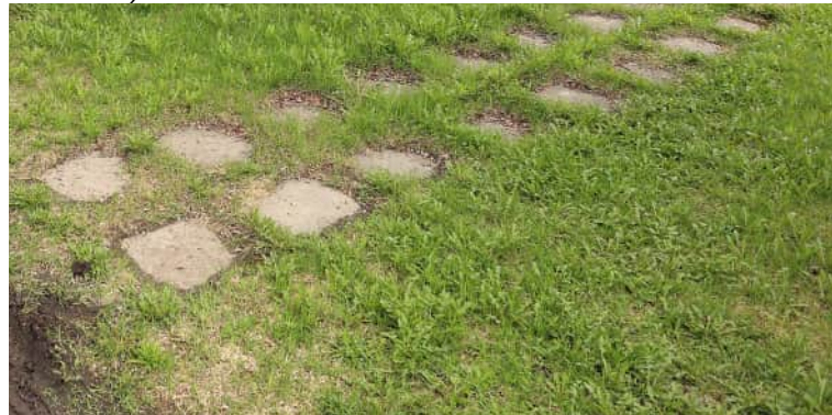
Kuva 98: Hyvin kosteutta läpäisevä, kevyt kivipolku. (Kuva: Riitta Kosonen, Arkkitehtitoimisto Jorma Teppo Oy, 18.5.2021)
