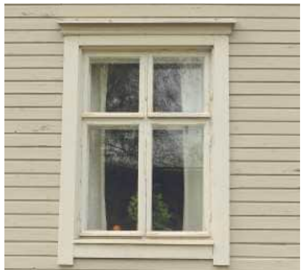
Kuva 34: 4-ruutuinen risti-ikkuna on tyypillisimpiä ikkunatyyppejä Raksilassa. (Kuva: Riitta Kosonen, Arkkitehtitoimisto Jorma Teppo Oy, 5/2021)
