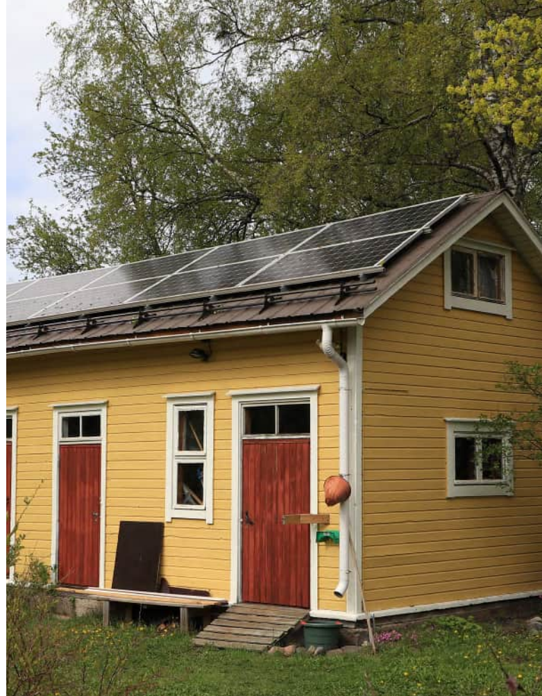
Kuva 103: Piharakennuksen katolle on lisätty aurinkopaneelit. (Kuva: Riitta Kosonen, Arkkitehtitoimisto Jorma Teppo Oy, 5/2021.)
