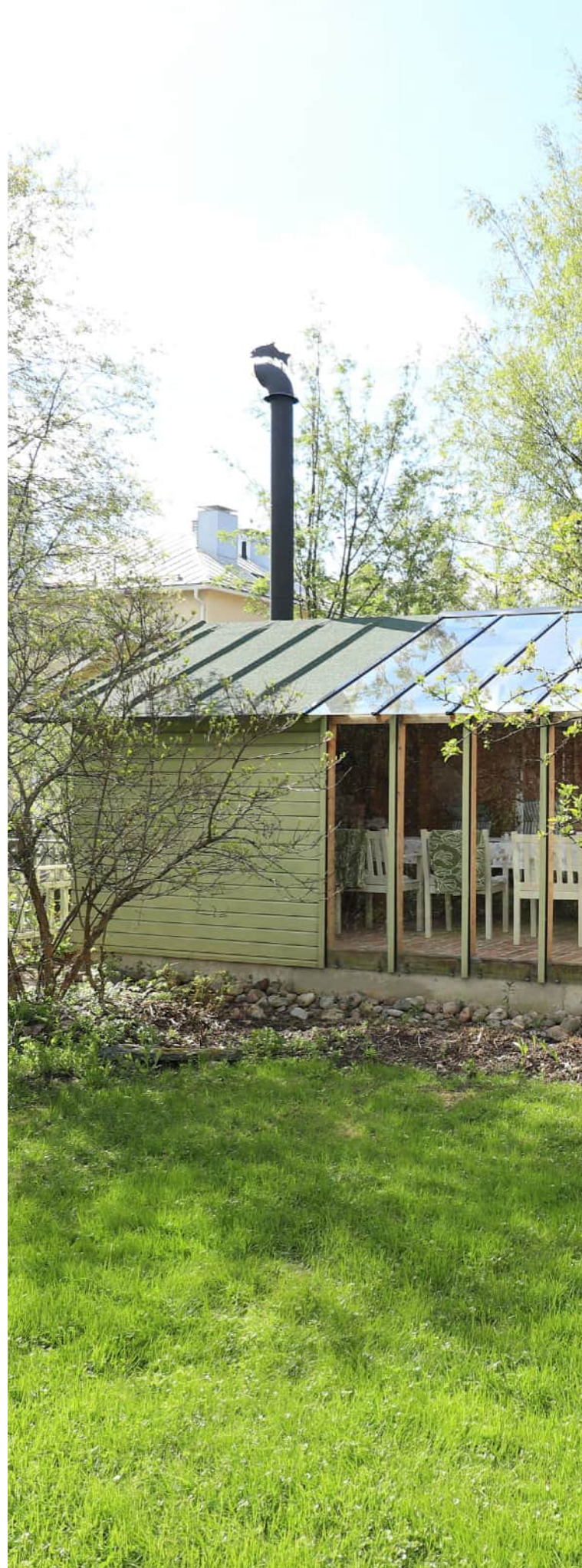
Kuva 85: Alkuperäisten talousrakennusten mittoja mukaileva uudisrakennus.
