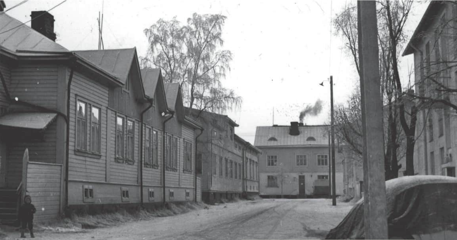
Kuva 5: Näkymä kadonneesta Raksilasta vuodelta 1962. Välikadun päätteenä on Syrjäkatu 11:ssä toiminut yleinen sauna. (Kuva: Museovirasto JOKA, Kaleva)
