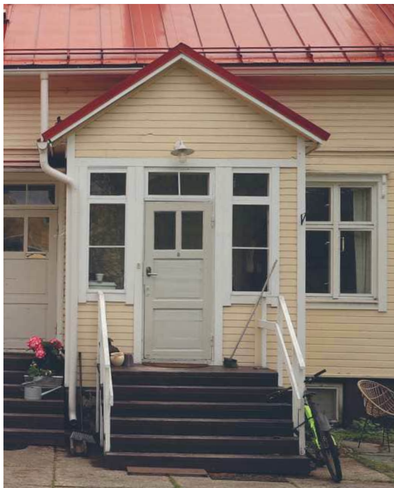
Kuva 75: 1930-luvun alun ulko-ovet. Peilijako on klassismille tyypillinen. (Kuvat: Riitta Kosonen, Arkkitehtitoimisto Jorma Teppo Oy, 5/2021)
