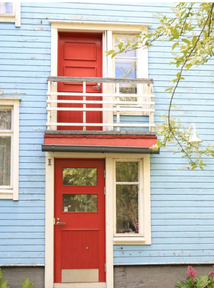
Kuva 74: Jälleenrakennuskauden klassismi, jossa funktionalismin piirteitä. (Kuva: Riitta Kosonen, Arkkitehtitoimisto Jorma Teppo Oy, 5/2021.)
